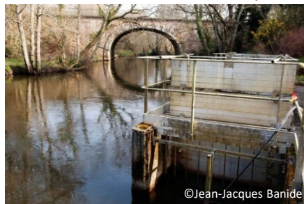
Point de captage d'eau sur le Steïr à l'usine de Troheïr, à Quimper
