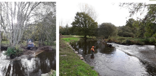
Réparation de la brèche du bief du Moulin du Cleuyou, sur la rivière du Jet à Ergué-Gabéric (novembre 2021)
