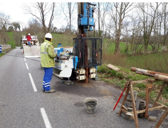
Réalisation d'un sondage carotté sur le remblai de la RD 50 entre Langolen et Coray.
