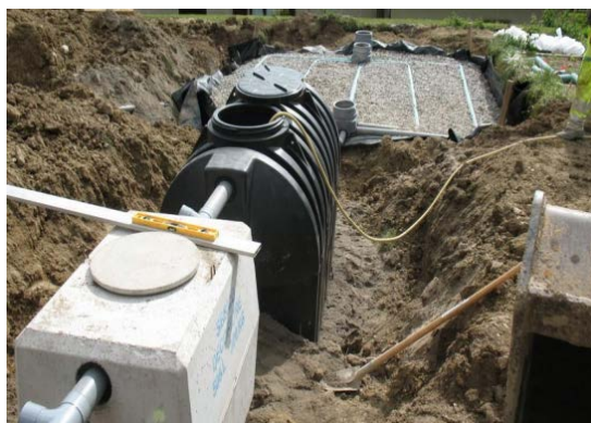
Réhabilitation d'un ANC
