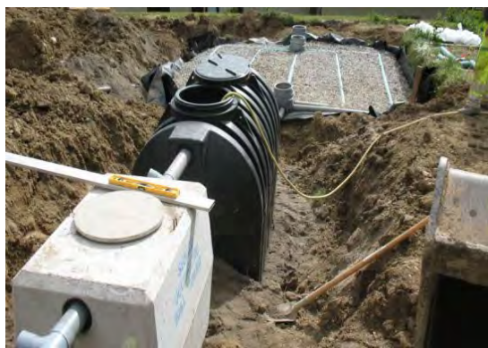
Réhabilitation d'un ANC
